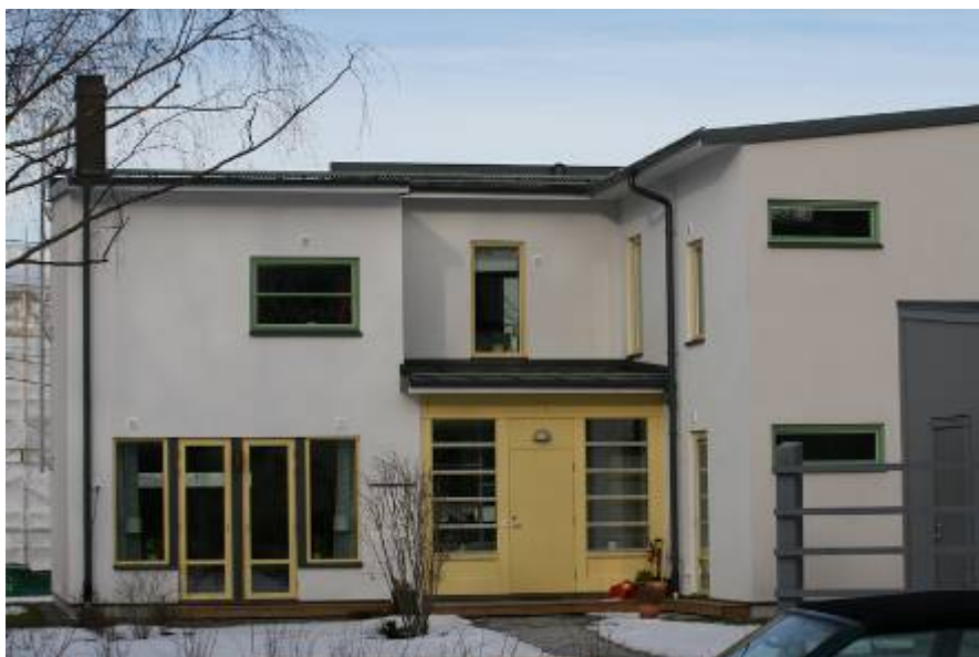
JMs Marinan i Saltsjöbaden är exempel på bostäder byggda i egen regi med hjälp av BIM.
